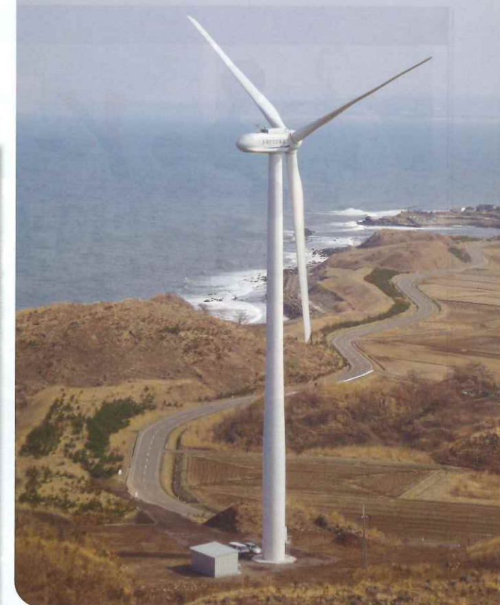
生活クラブの風力発電所(2,000kW、秋田県にかほ市)
